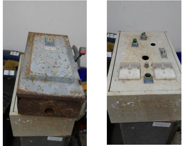
11. ตู้ควบคุมระบบไฟ
